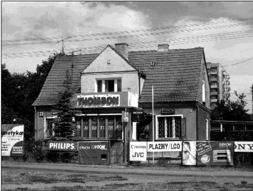
Ryc. 1. Przykład braku wpływu projektanta na użytkowanie obiektu. (fot. K. Kopeć)
